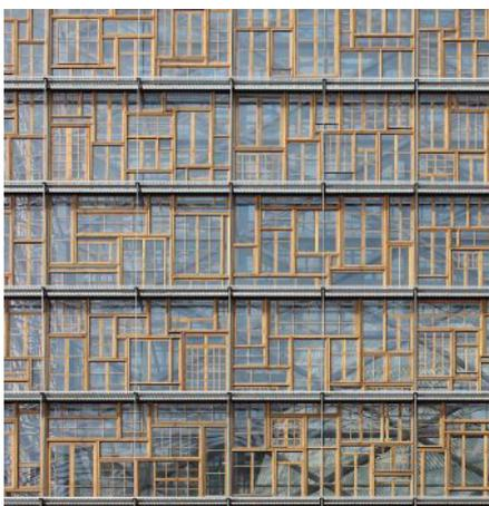
Façade en châssis recyclés, siège du Conseil de l'Union Européenne
